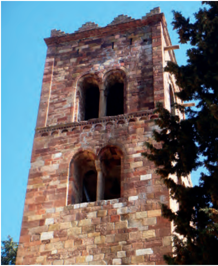
Detalle de la fachada oeste de la torre
