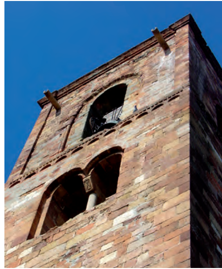
Detalle de la fachada sur de la torre
