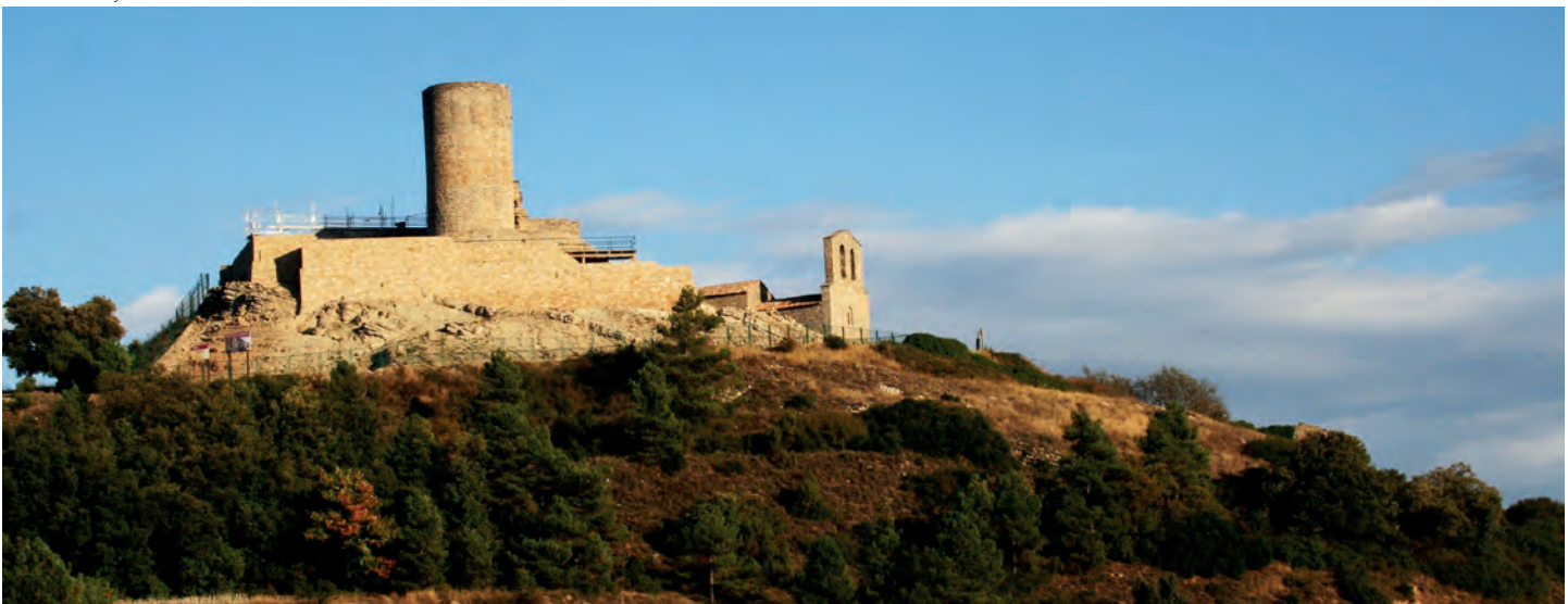
Vista del conjunto de Boixadors
