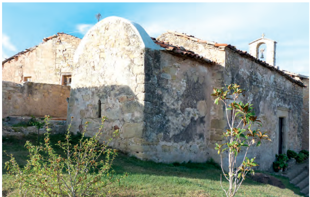
Vista general de la cabecera
