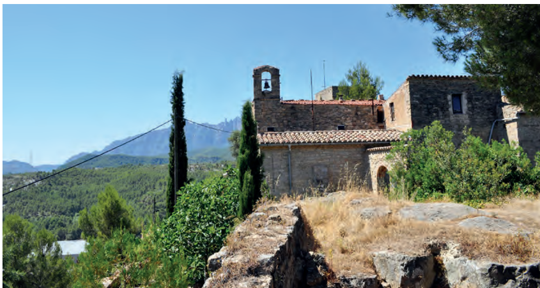
Vista general del actual edificio
