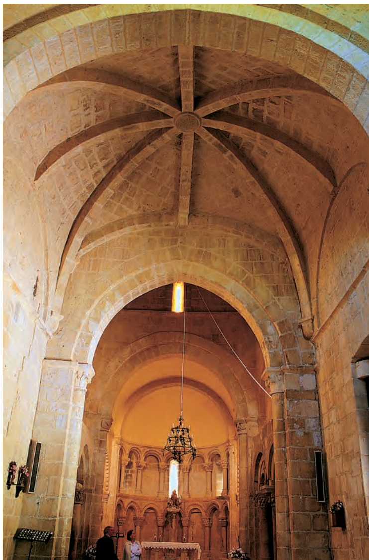
Santa María de Siones. Nave: bóvedas y ábside
