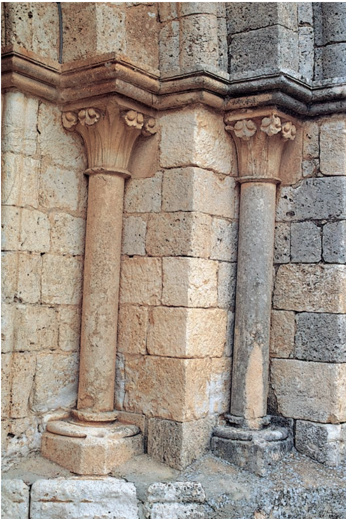
Columnas de la portada
