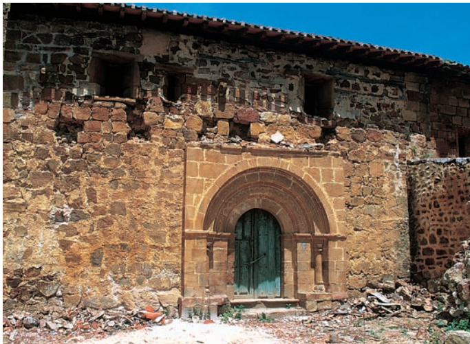
La fachada meridional en junio de 2002
