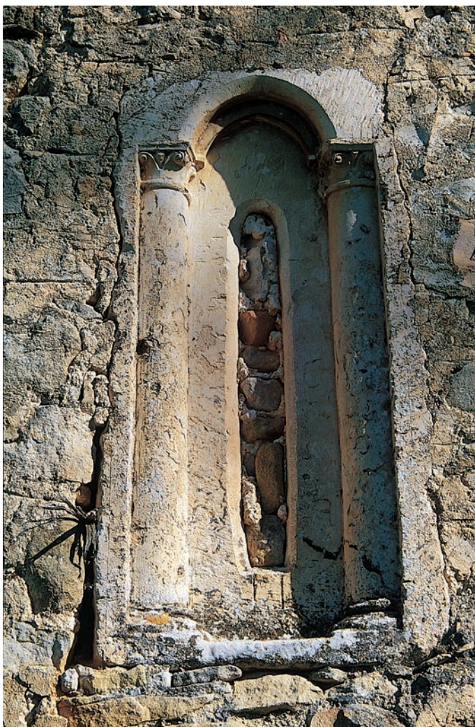
Ventana reutilizada en el hastial occidental de la nave
