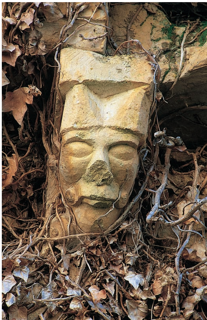
Canecillo del muro norte de la nave
