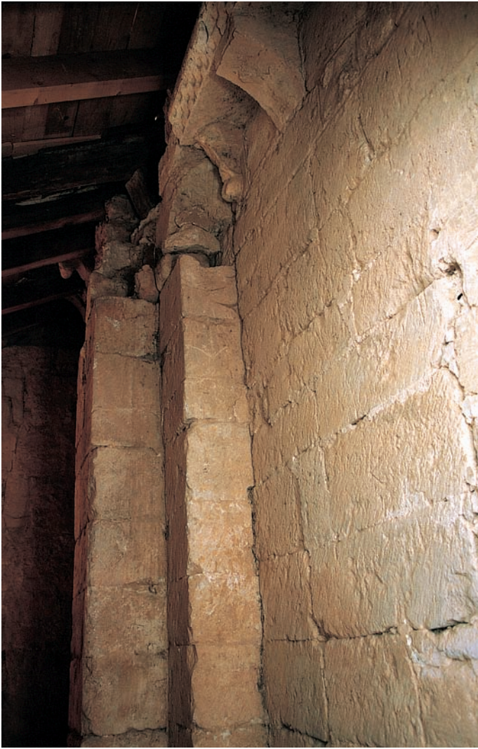
Restos de la antigua fachada sur
