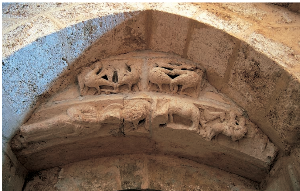
Detalle de la portada en el interior de la nave
