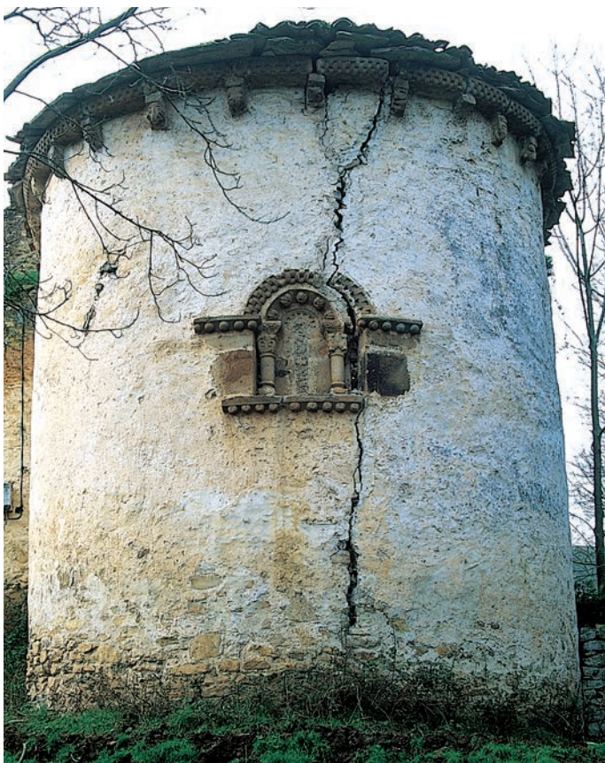
Exterior del ábside
