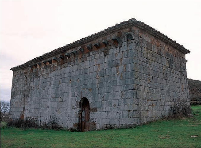
Fachadas norte y oeste
