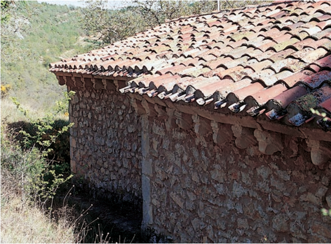
Detalle del muro norte
