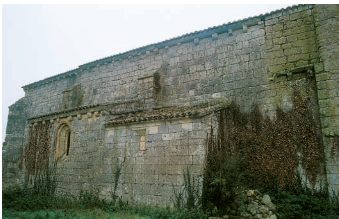
Fachada septentrional, con los restos románicos junto a la torre
