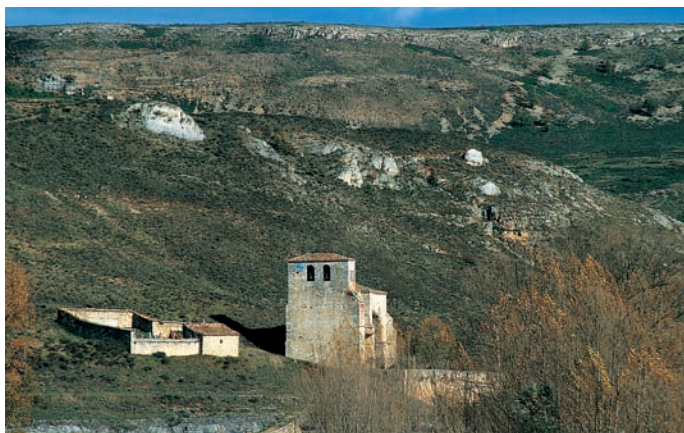
Vista general de la iglesia
