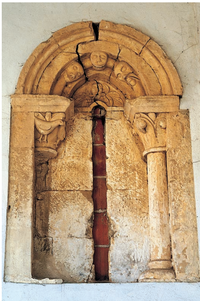
Ventana del tercer tramo de la nave
