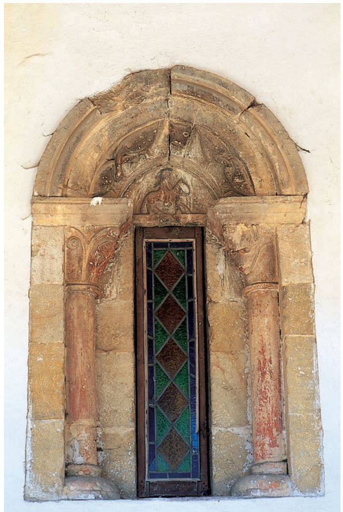
Ventana del primer tramo de la nave
