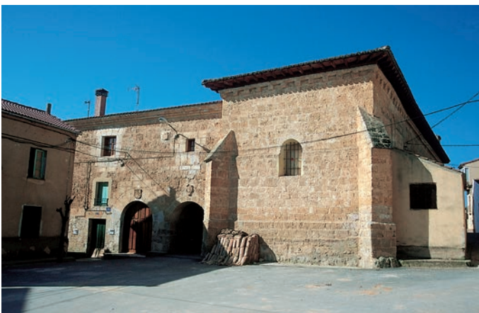
Cabecera de la iglesia y casas del priorato dependiente de Arlanza
