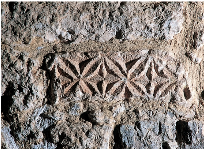
Relieve en el muro interior de la nave
