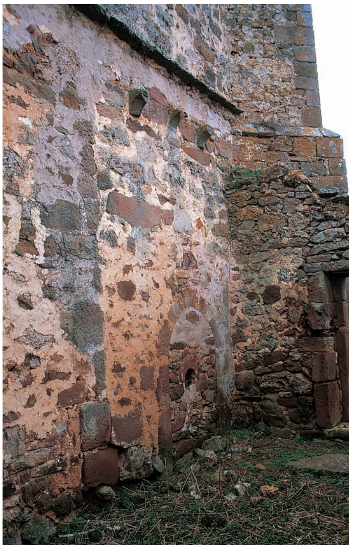
Restos románicos en el muro norte de la nave
