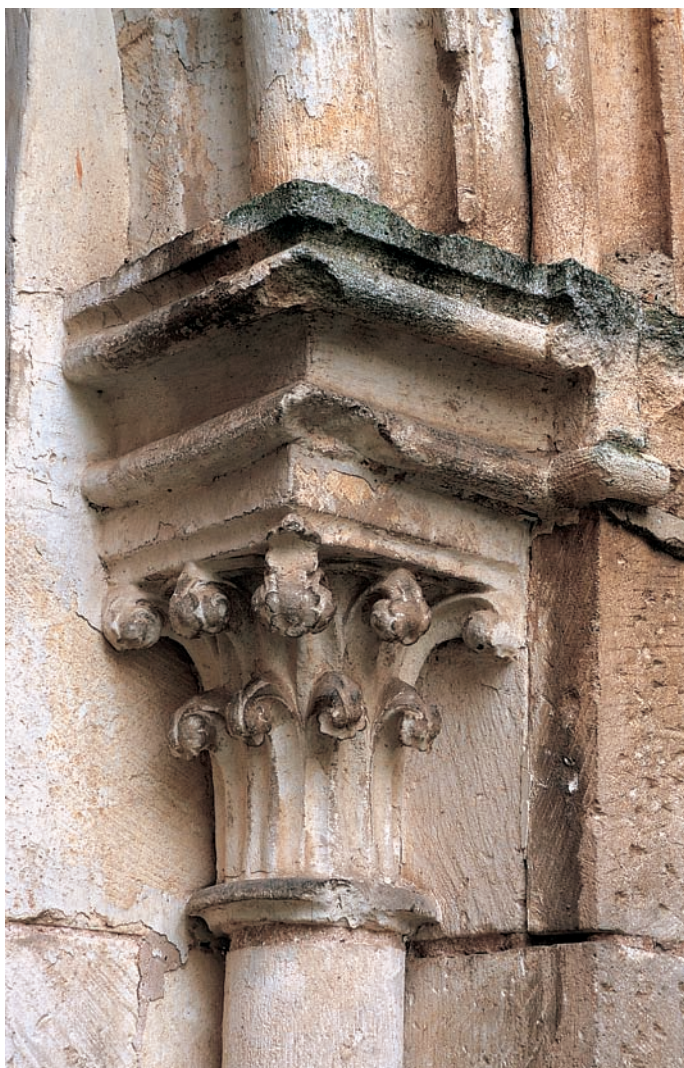
Capitel de la puerta norte de la iglesia
