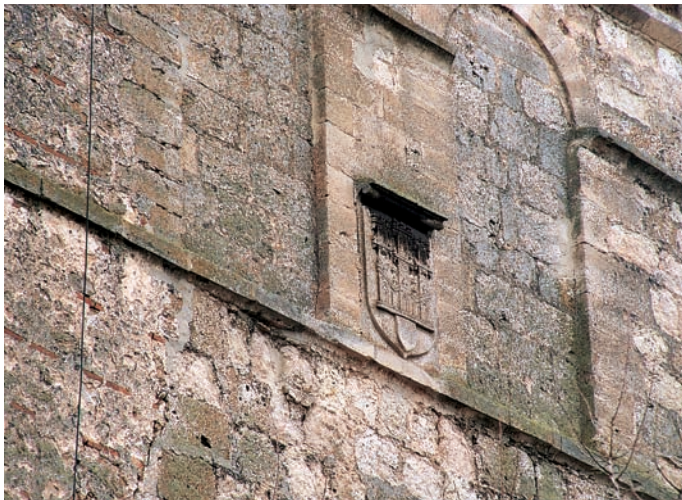
Detalle de la fachada norte de la torre
