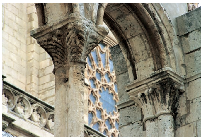
Detalle de las arcadas
