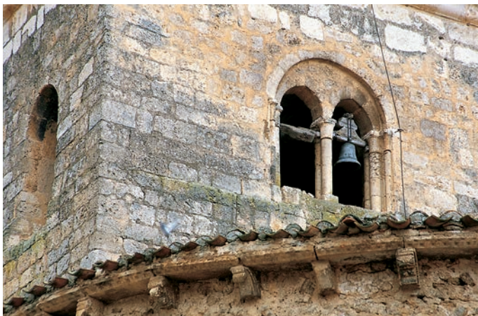
Ventanal norte de la torre
