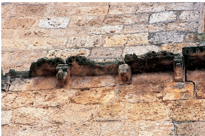
Cornisa que separa los dos cuerpos de la torre
