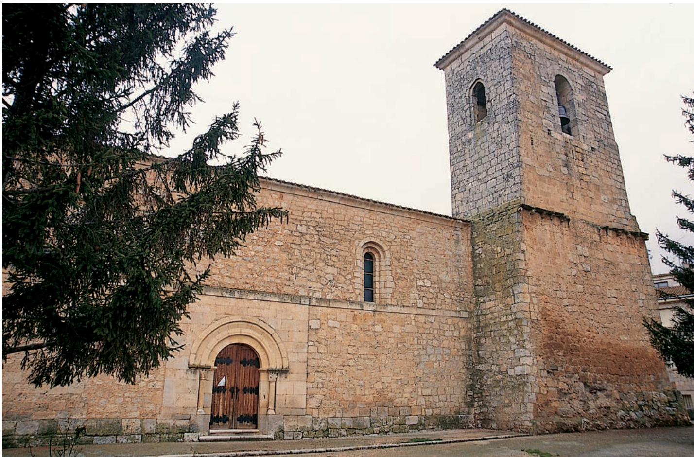
La iglesia vista desde el sur
