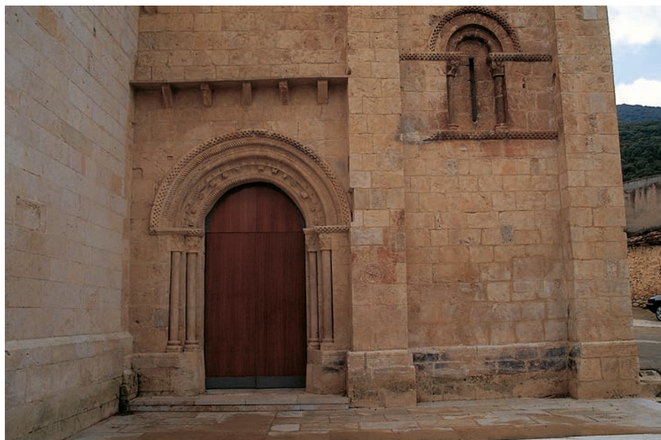
Detalle de la fachada norte de la nave
