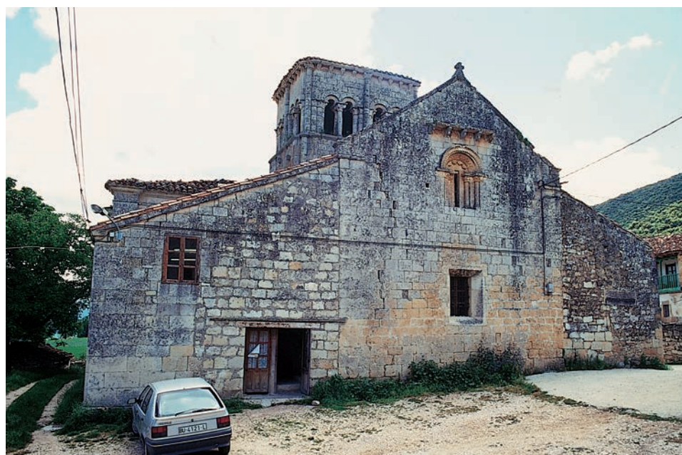
Fachadas norte y oeste antes de la intervención de 1996
