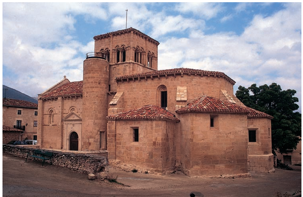
Iglesia de San Nicolás tras la restauración de 1996. Vista desde el sureste
