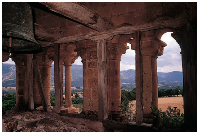
Interior de la torre antes de la restauración
