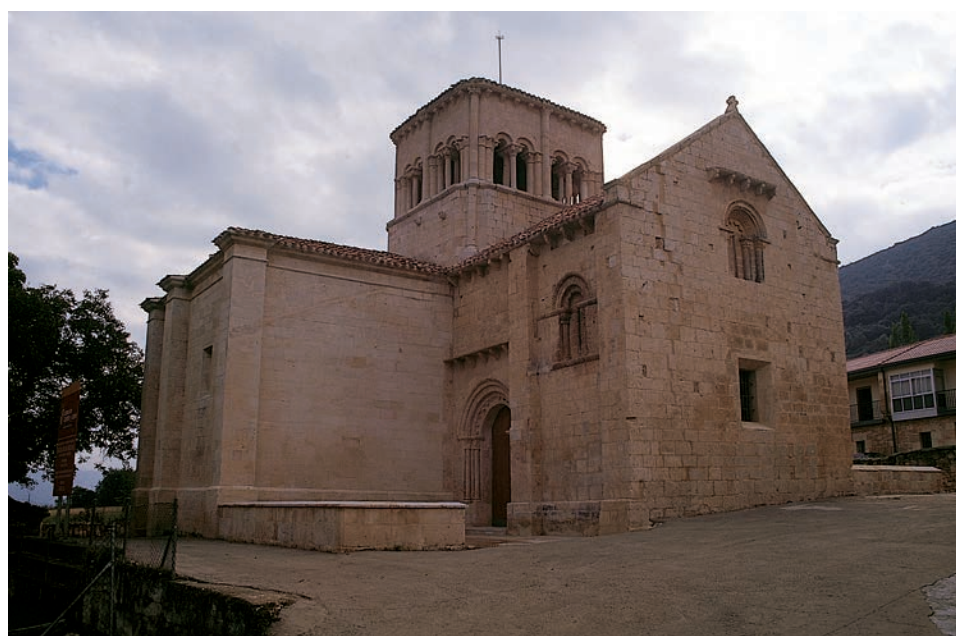
Fachadas norte y oeste después de la intervención de 1996
