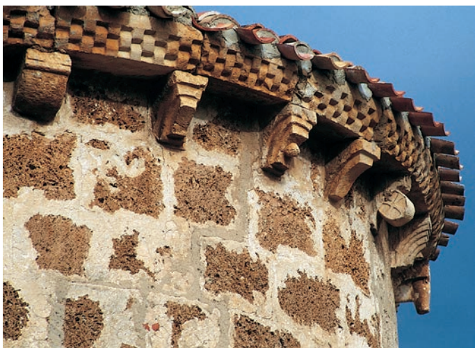
Alero del ábside
