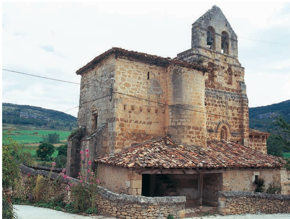
Fachada sur, antes de la restauración
