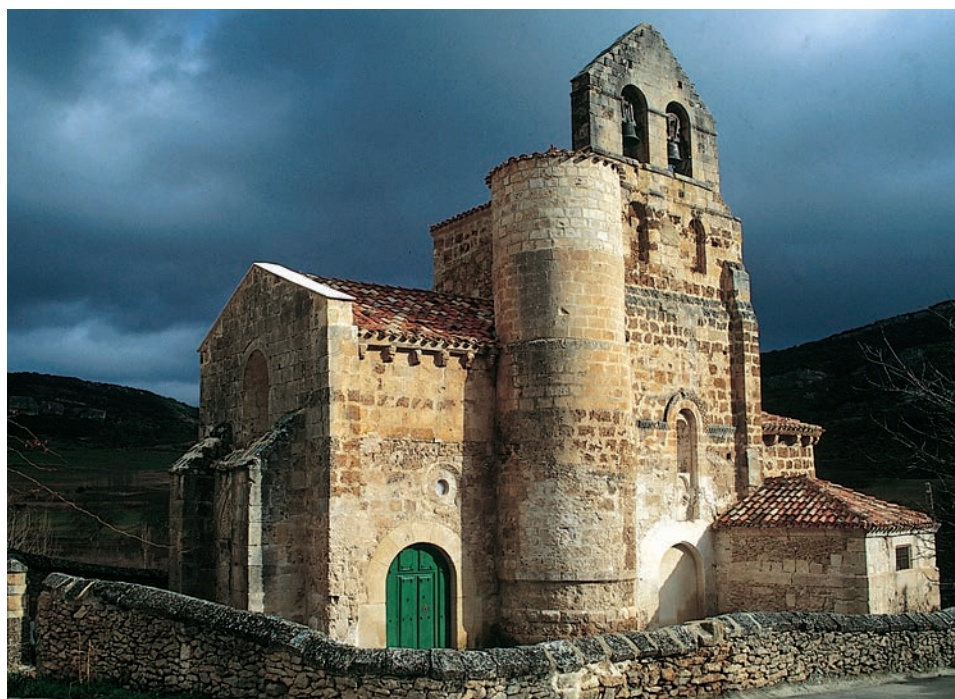
Fachada sur, después de la restauración
