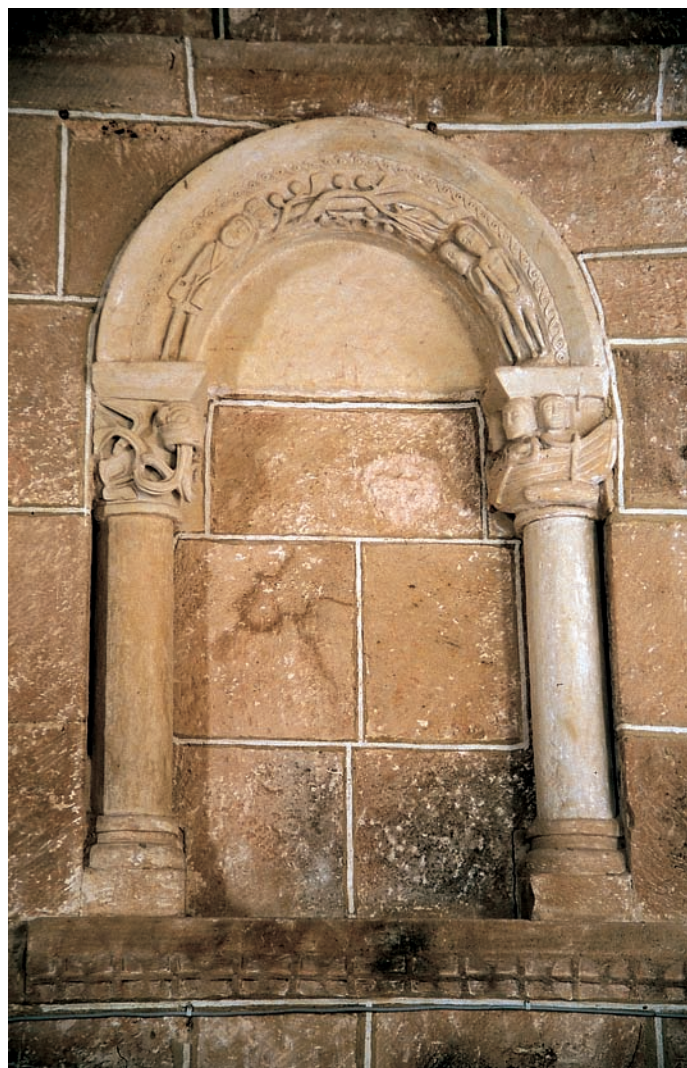
Arco del muro norte del presbiterio
