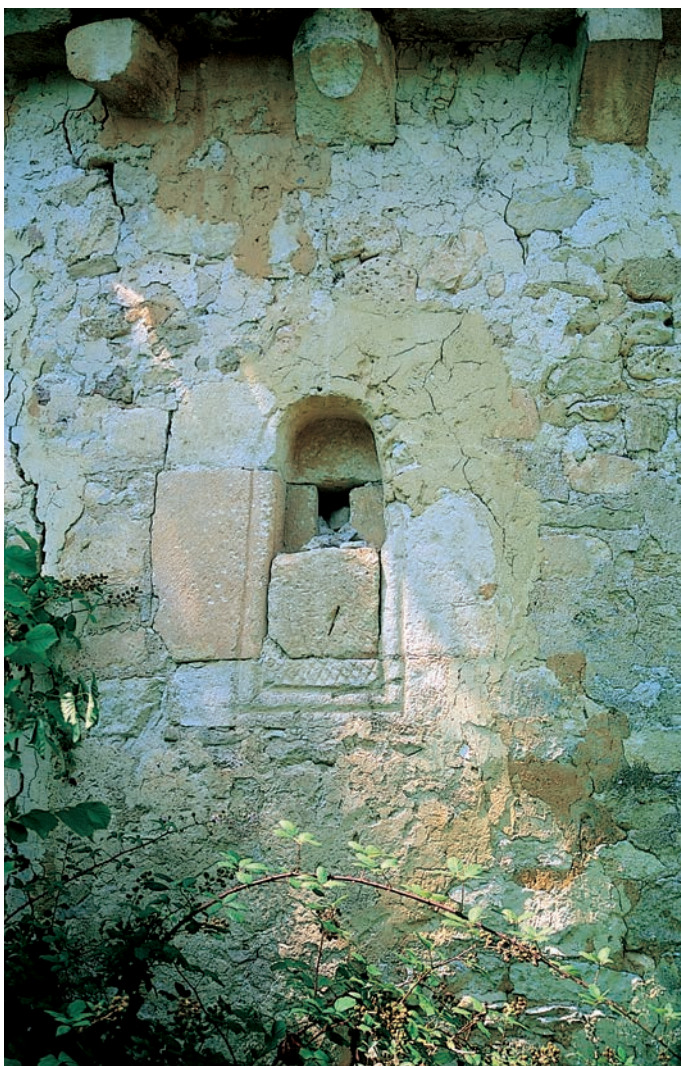
Ventana del ábside
