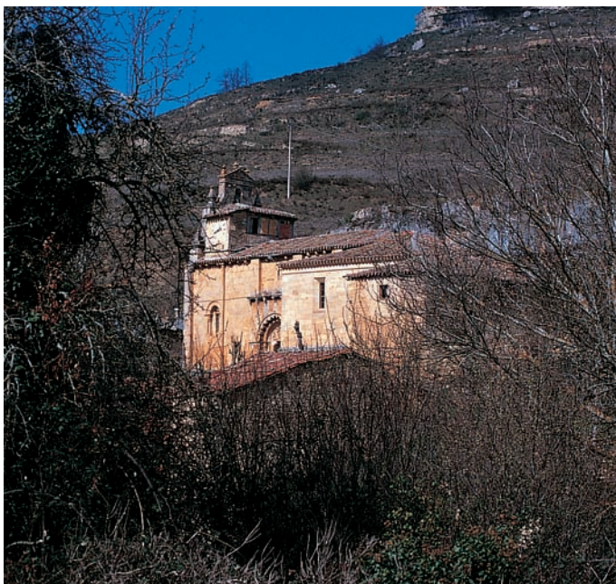
Panorámica de la iglesia, antes de la restauración
