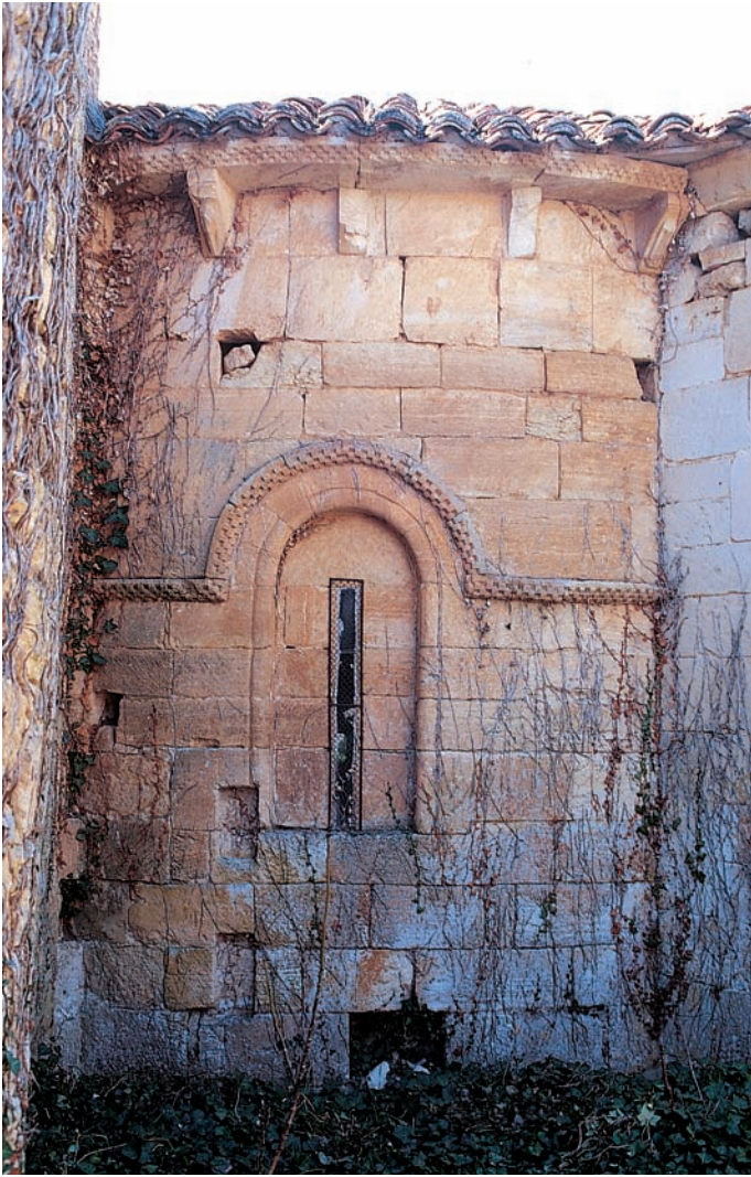
Exterior del ábside, antes de la restauración
