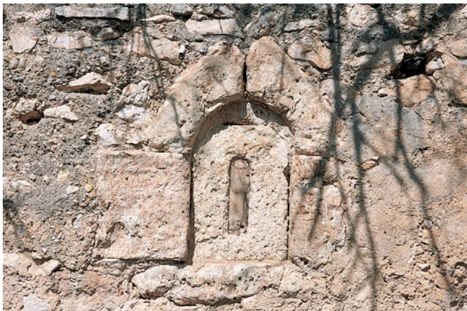
Ventana en el muro sur de la cabecera
