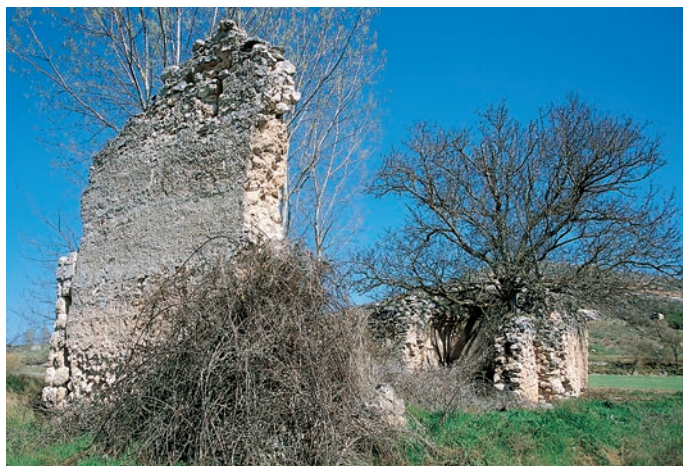
Las ruinas de la ermita vistas desde el suroeste
