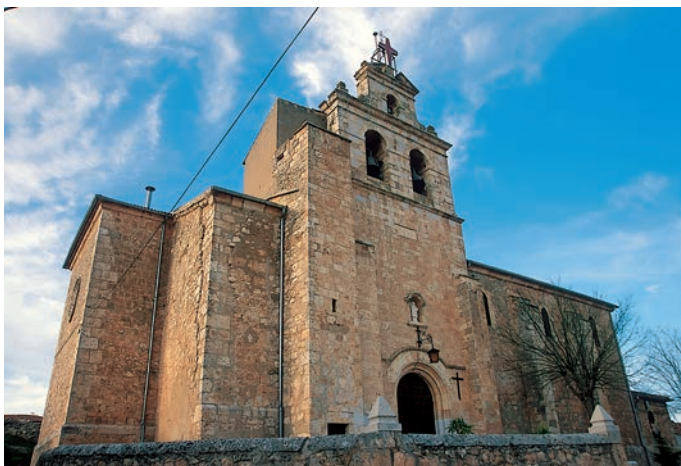
Vista general de la iglesia desde el sur
