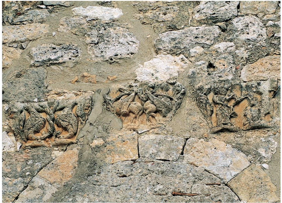
Capiteles en el bastial de la nave
