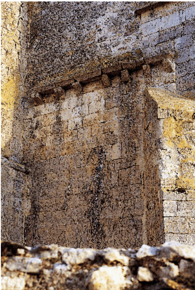
Detalle del muro norte
