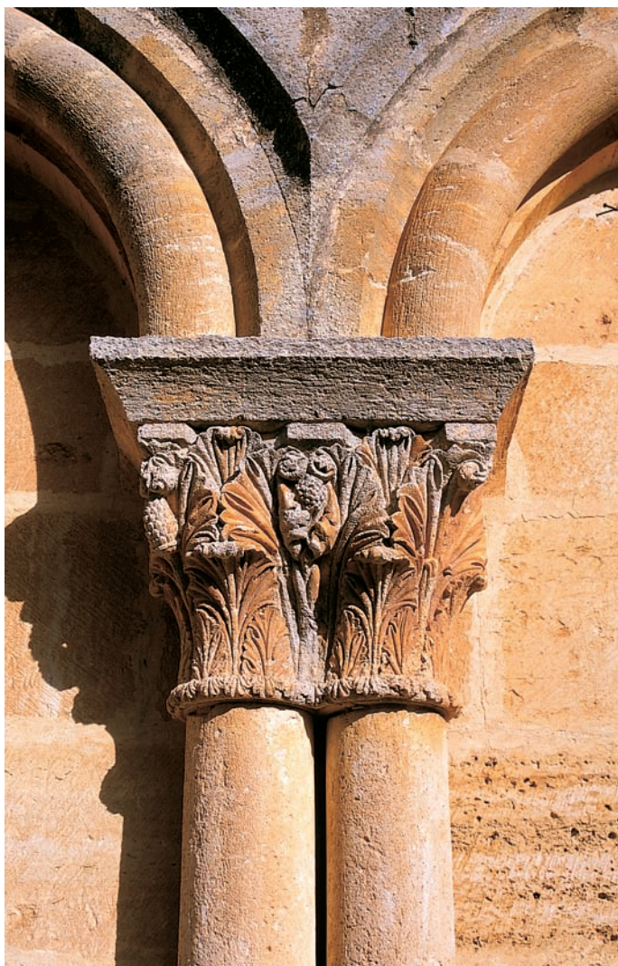
Capitel vegetal de la arquería exterior
