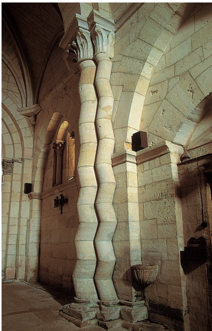
Detalle del interior
