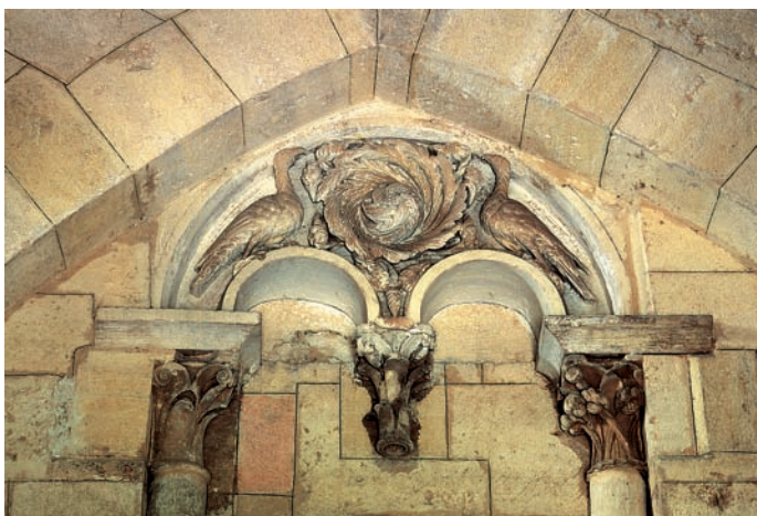
Interior. Arquería decorativa
