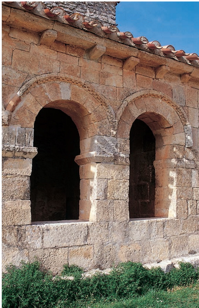
Detalle del pórtico
