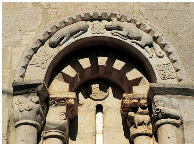
Detalle de la ventana central del ábside
