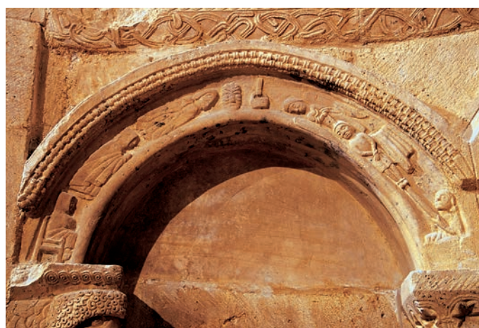
Arco del nivel inferior del ábside
