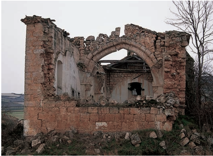
Vista de la cabecera derruida y del arco triunfal
