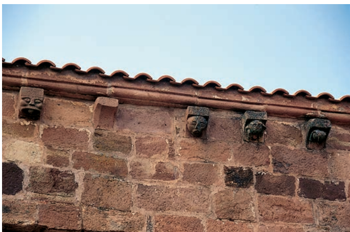
Canecillos del muro sur
