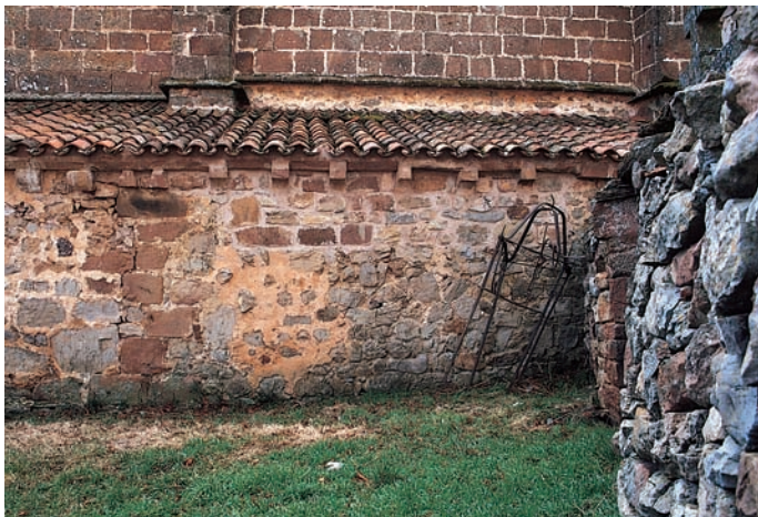
Estructura de la fachada norte
