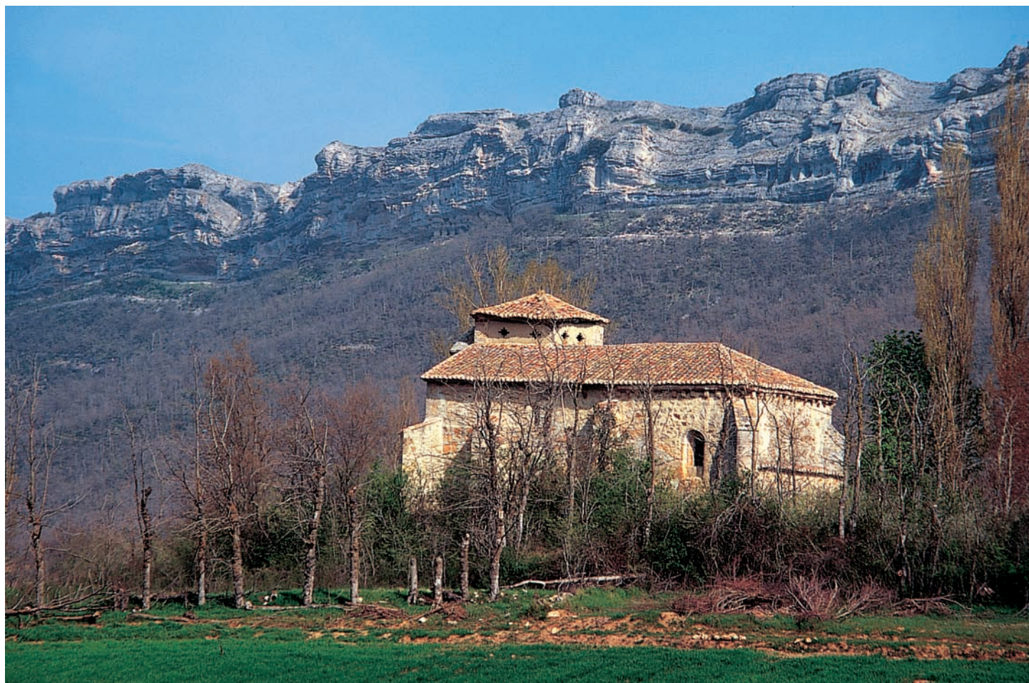
La iglesia vista desde el sur
