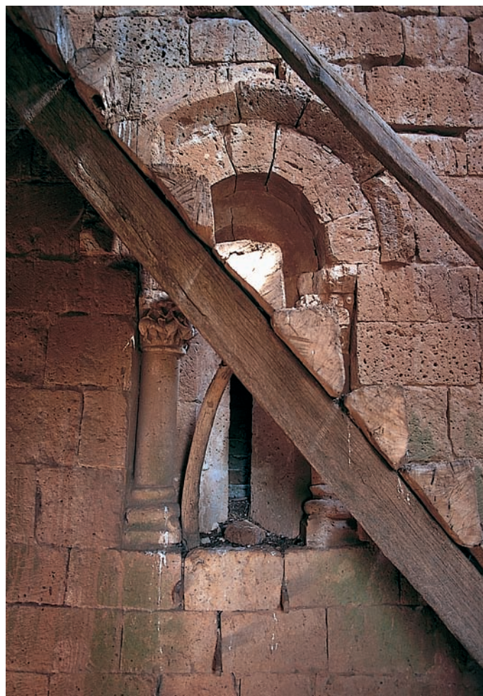
Ventanal del muro oeste
