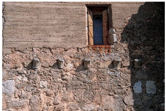
Canecillos del muro sur
