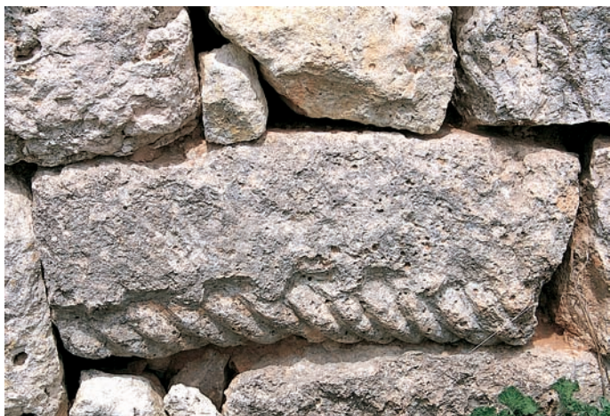
Dovela románica reutilizada en el muro
