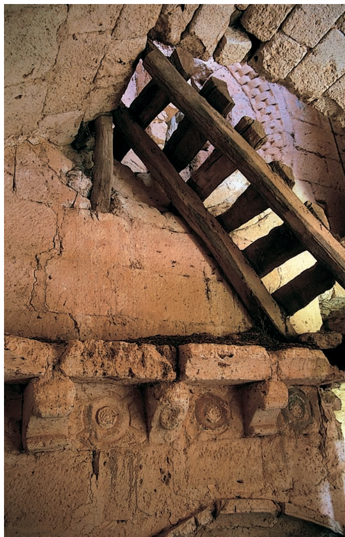
Interior del cuerpo bajo de la torre con los restos de la primitiva portada occidental y del óculo situado sobre ella
