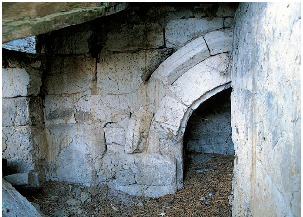
Arco en el muro sur de la antigua cabecera
