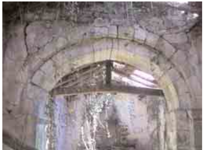
Interior de la ermita antes de la restauración
