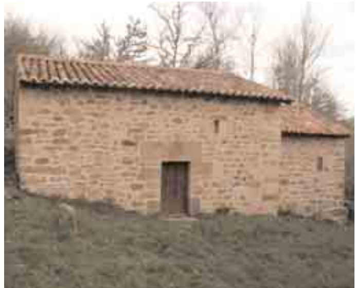
Aspecto actual del exterior de la ermita
