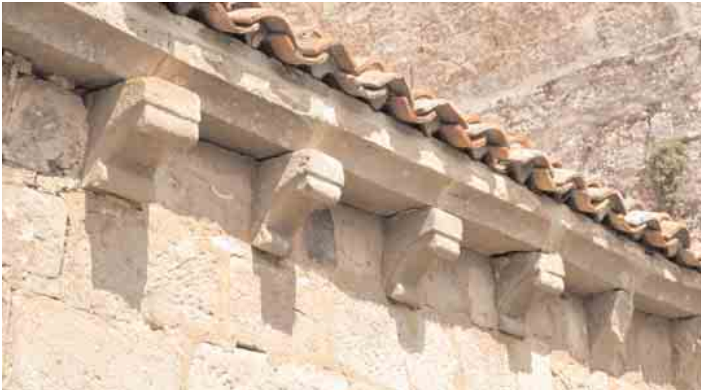
El muro sur con sus canecillos 3 a 7
