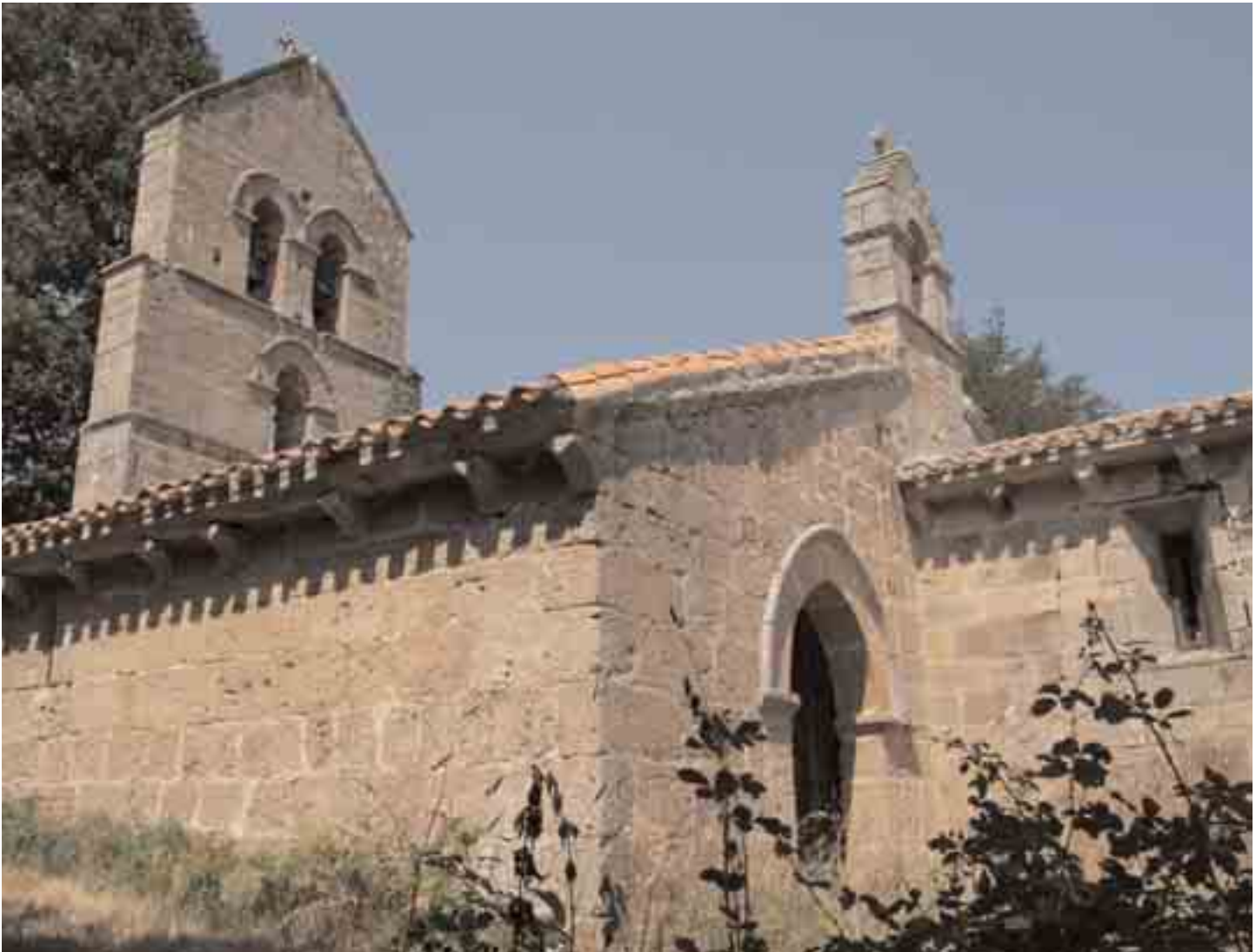
Iglesia de San Miguel, desde el SE, mostrando las dos espadañas y sus canecillos de proa de nave
