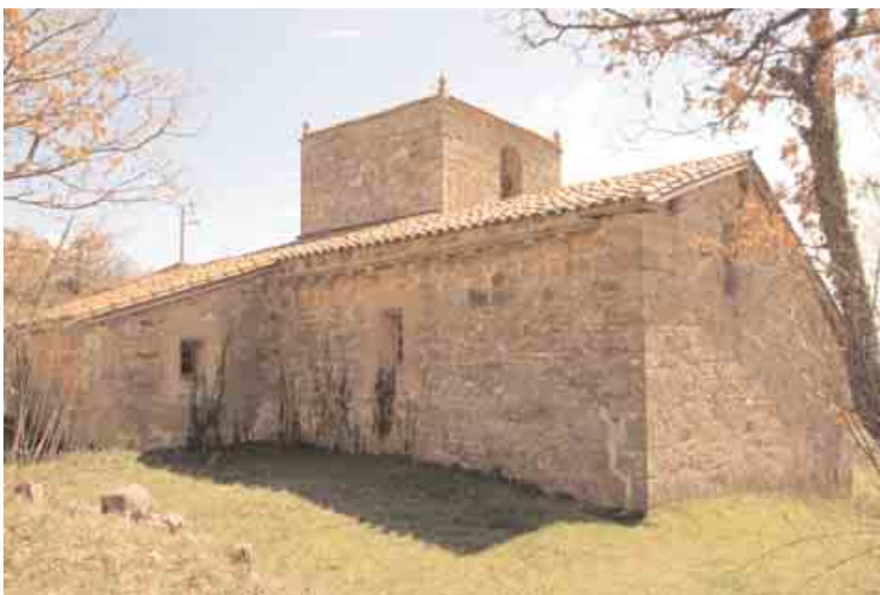
El muro norte de la iglesia, con sus trece canchillos de caveto
