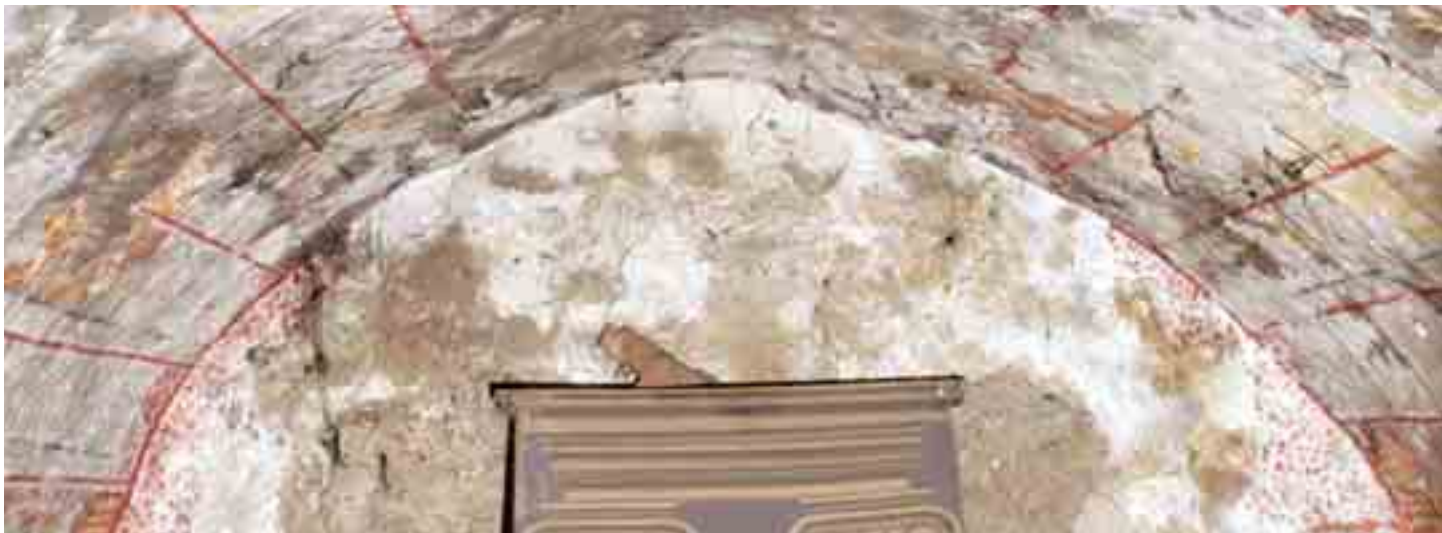
El viejo ábside y la bóveda de cañón apuntado, únicos restos de carácter románico que permanecen en la iglesia
