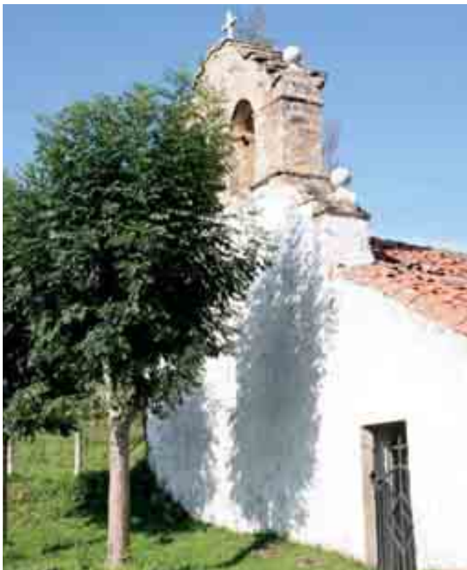
Detalle de la espadaña y añadido del pórtico-nave al sur, con su entrada
