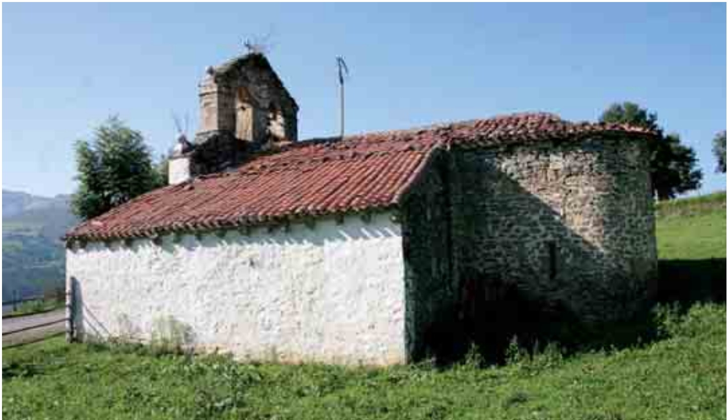
Aspecto de los muros meridionales de Santa Marina
