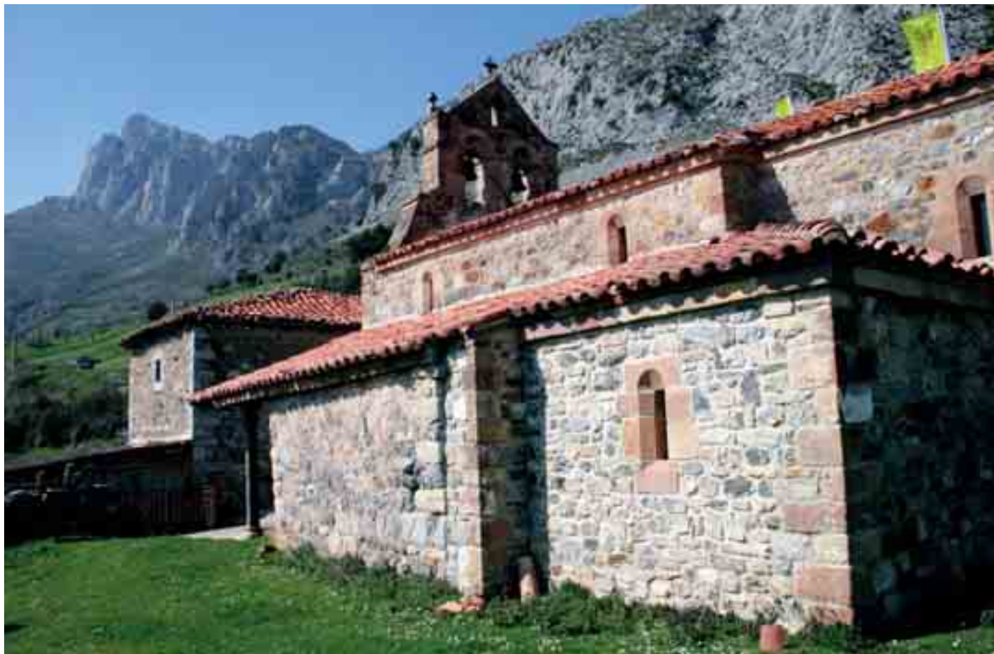
Vista de la iglesia con la espadaña al fondo
