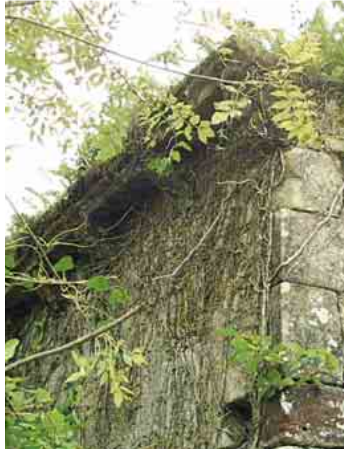
Vista del muro norte con canecillos
