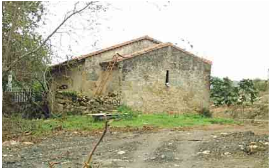
Vista de la cabecera desde el Este
