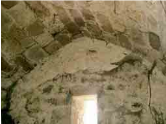
Bóveda de cañón y ventana absidal
