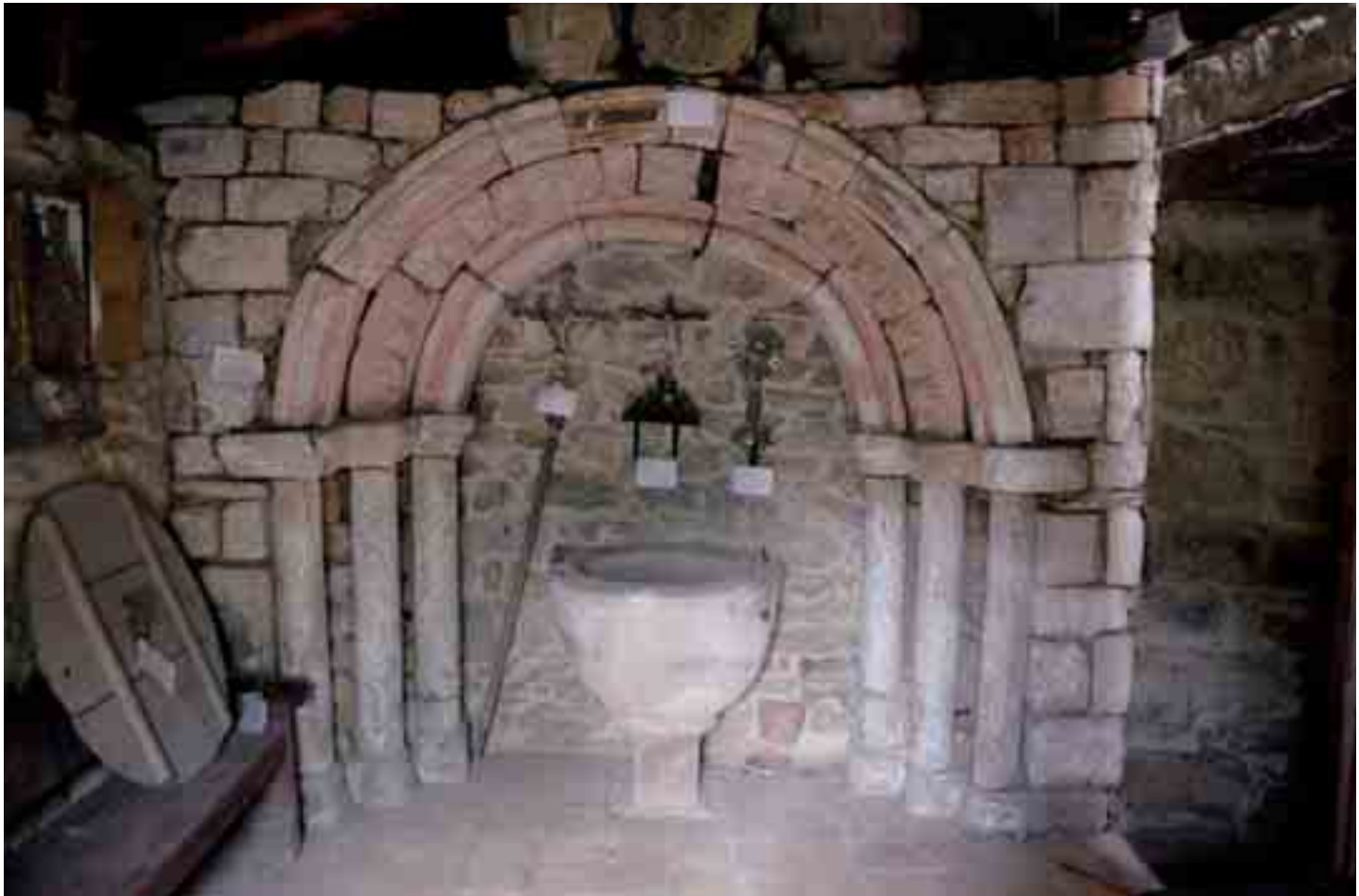
Puerta románica colocada en la sacristía
