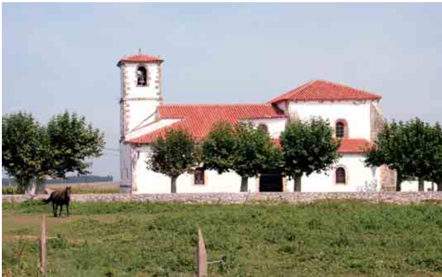
Vista general de la iglesia
