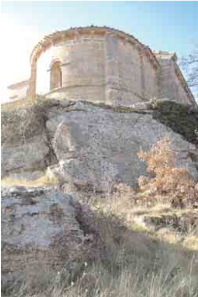
Visión del ábside con la peña donde está edificado
