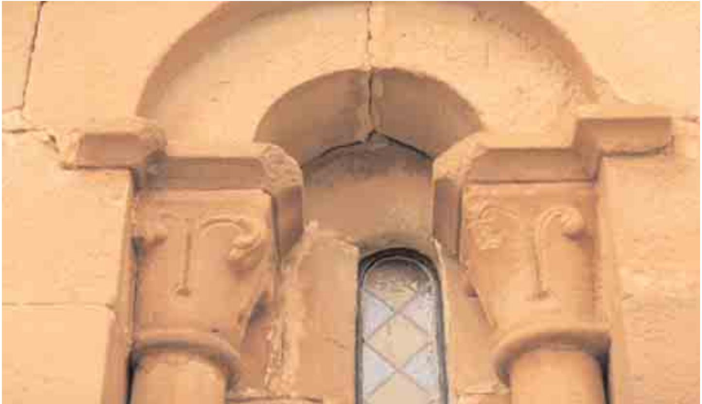
Detalle del arco y capiteles de la ventana del muro sur de la capilla absidal
