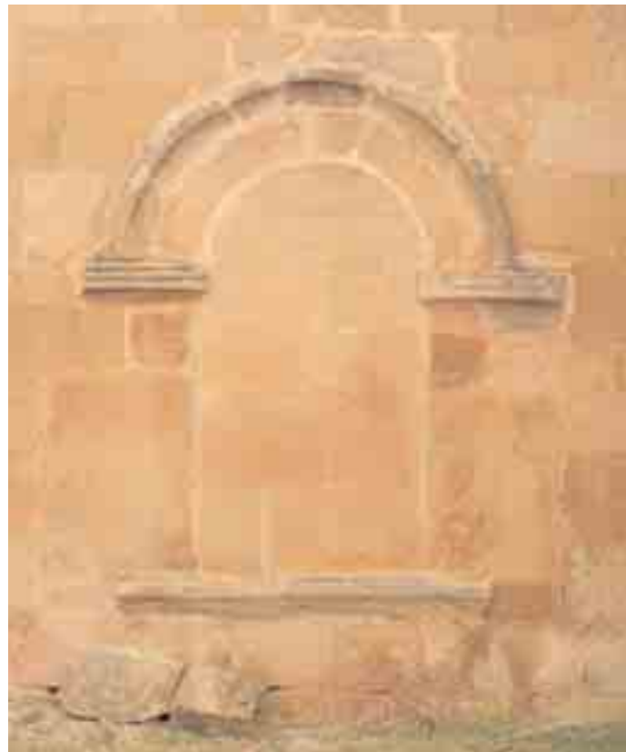
Puerta occidental, tardorrománica situada en el bajo de la espadaña. Hoy tapiada
