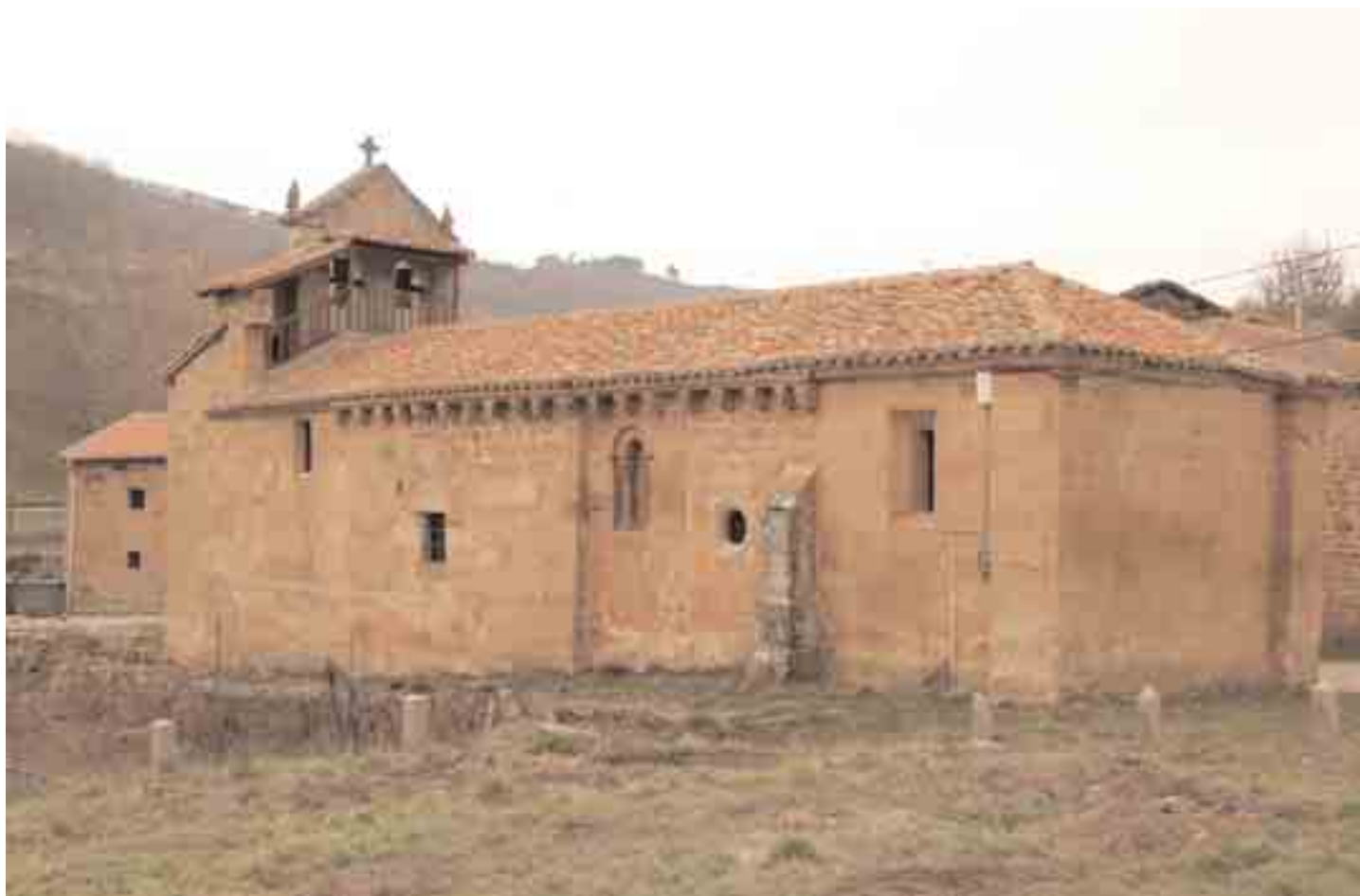
Aspecto general de la iglesia mostrando su muro sur
