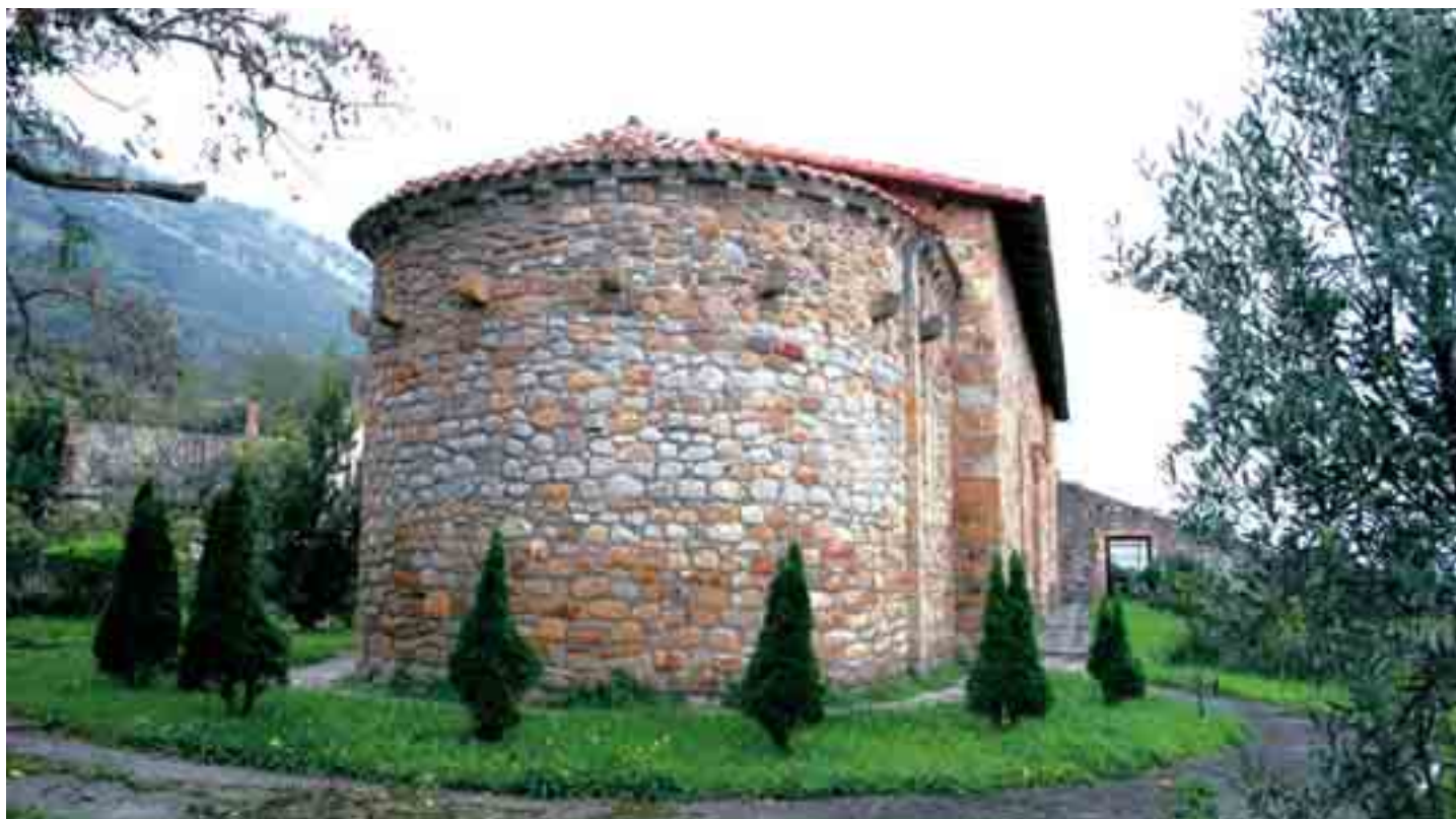
Vista general del ábside
